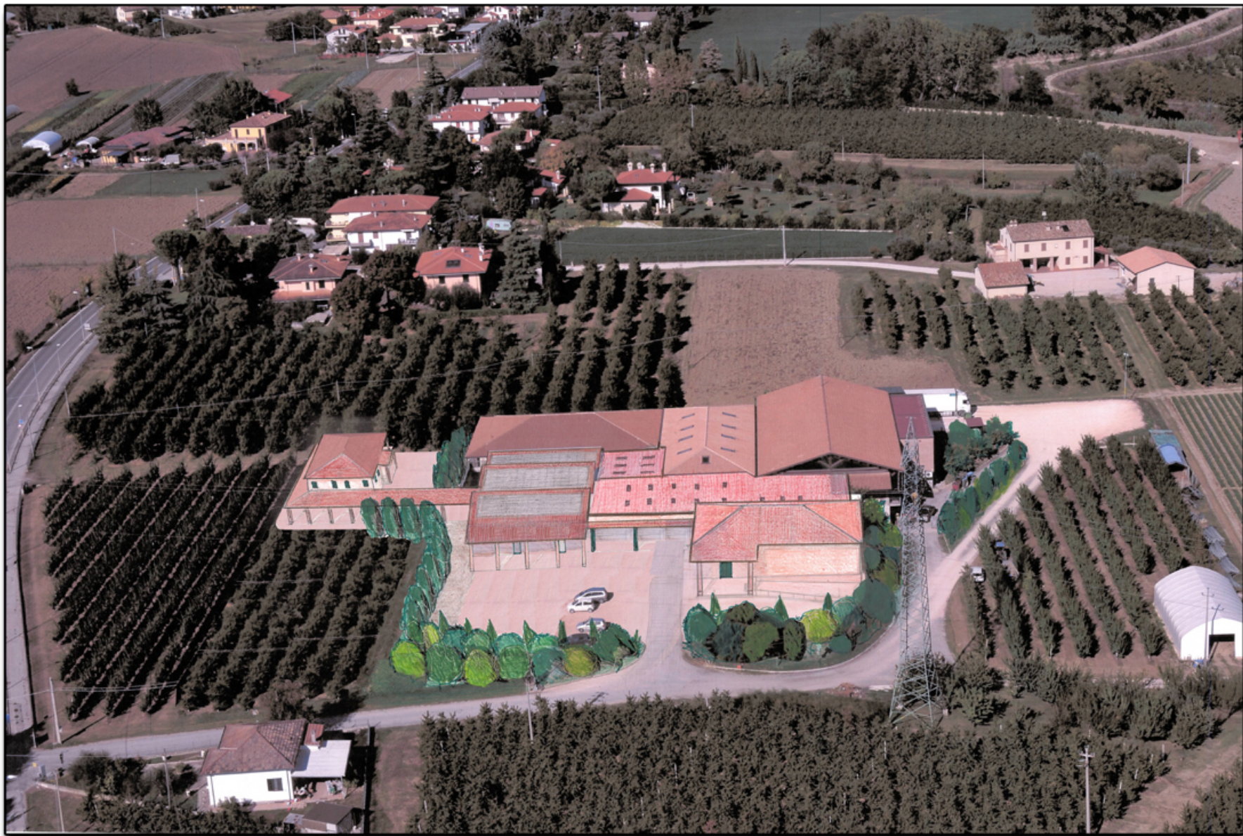
FOTO INSERIMENTO PROGETTO - VISTA AEREA DA VIA CALATOIO SANTARINI
