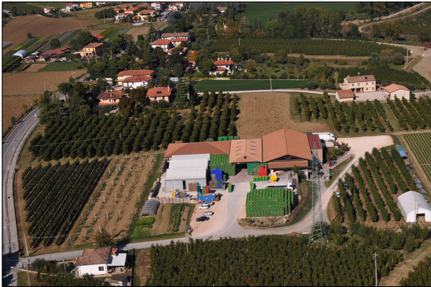
RILIEVO FOTOGRAFICO STATO DI FATTO - VISTA AEREA DA VIA CALATOIO SANTARINI
